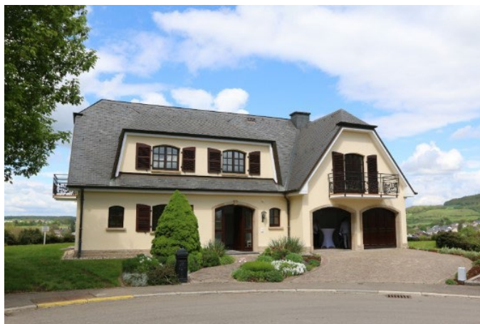
Logements pour jeunes– Schënnbiérg à Munsbach
