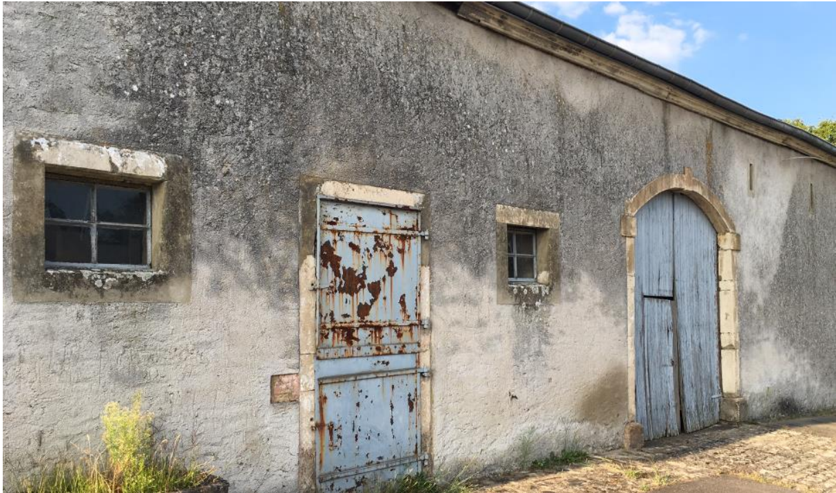
Abbildung 6: Bauruine westlich der Fläche I20
