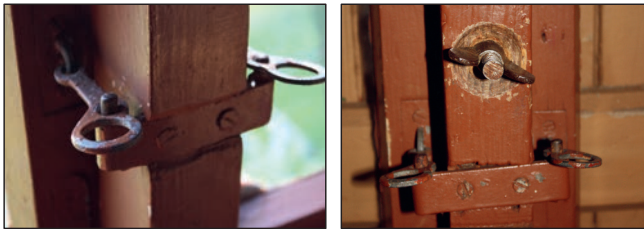
Einfach Methode fir di eenzel Elementer vun der Holzkonstruktioun, wéi beim Baukasten, mateneen ze verbannen. Beispill aus enger RAD Brak, déi mir zu lerseng entdeckt hunn (Archiv MT)
